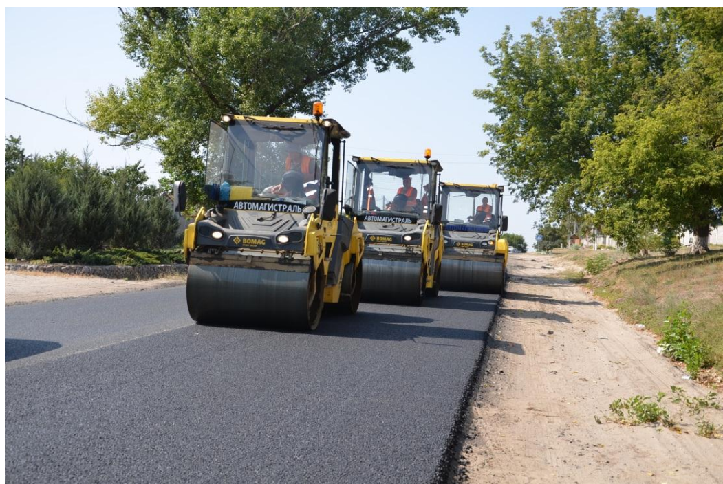
Рис. 5.10 – Ущільнення шару з щебенево-мастикової асфальтобетонної суміші гладковальцевими котками
