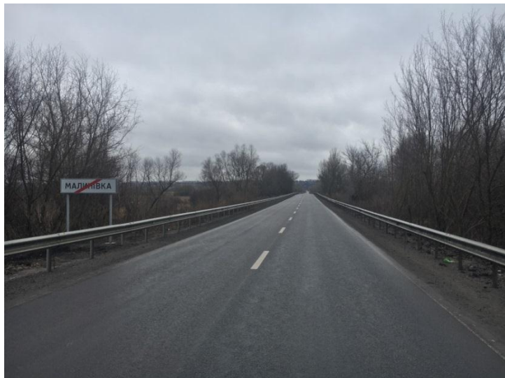
Рис. 5.11 – Загальний вигляд поверхні покриття з ЩМА-20 на ділянці автомобільної дороги Н-26 «Чугуїв – Мілове» після одного року експлуатації
