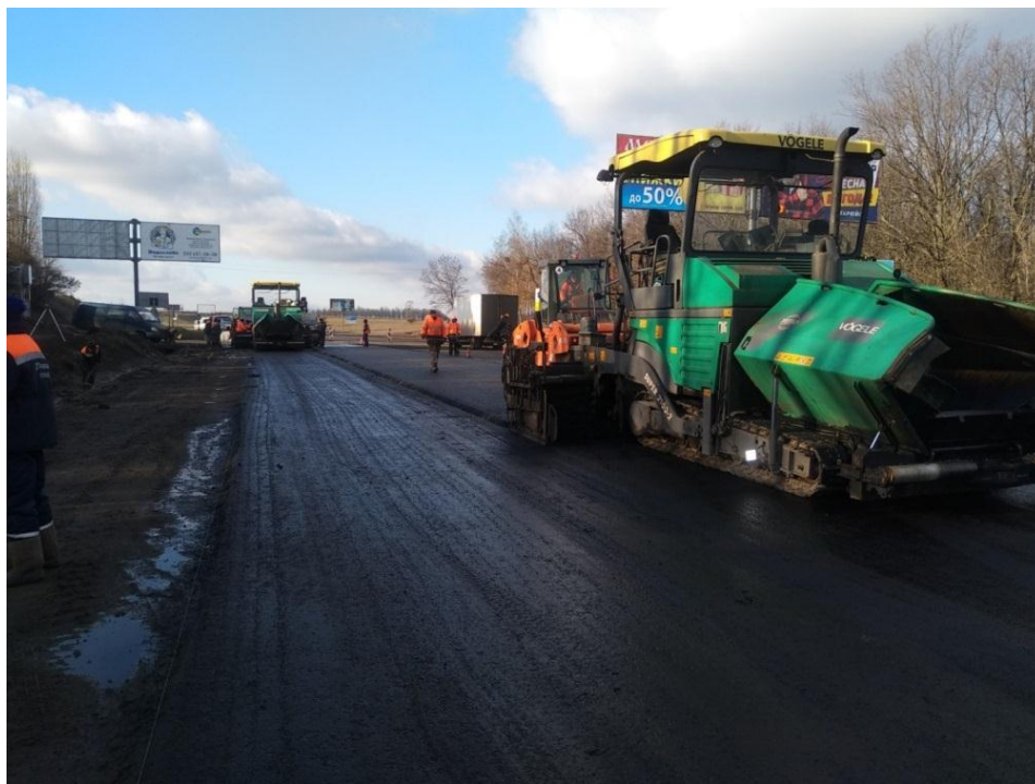
Рис. 5.3 – Процес укладання щебенево-мастикової асфальтобетонної суміші
