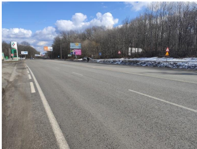
Рис. 5.5 – Загальний вигляд ділянки на другий рік експлуатації
