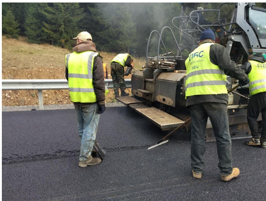
Рис. 5.16 – Влаштування поздовжнього шва
