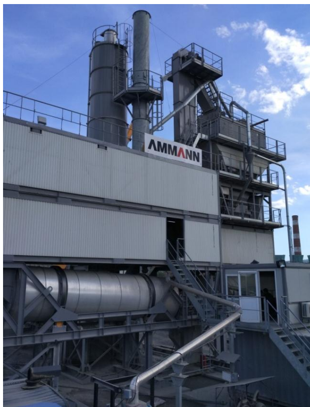
Рис. 5.13 – Загальний вигляд асфальтозмішувальної установки AMMANN моделі ABT 140-180 QUICKBATCH
