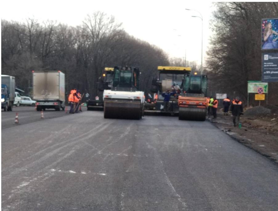
Рис. 5.4 – Ущільнення суміші гладковальцевими катками НАММ HD 110 та НАММ HD 130
