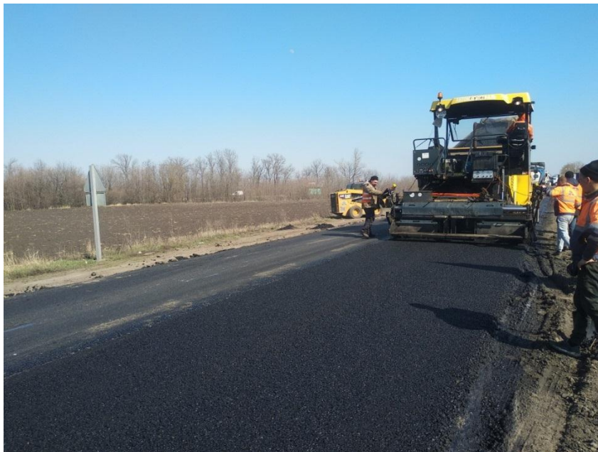
Рис. 5.7 – Процес укладання щебенево-мастикової асфальтобетонної суміші асфальтоукладачем
