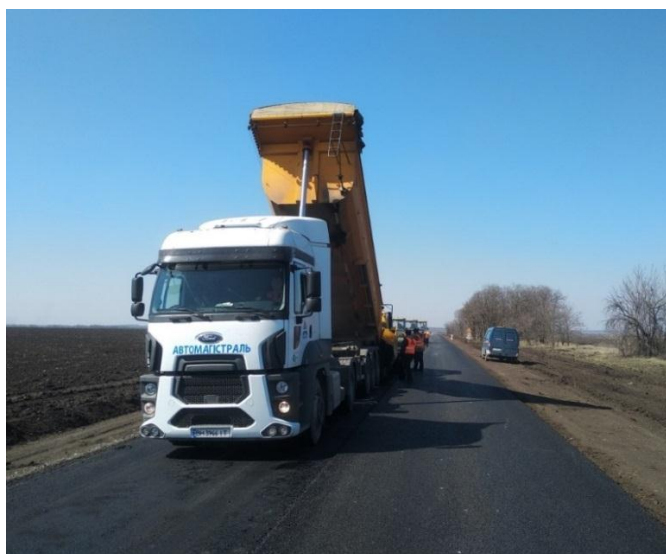
Рис. 5.6 – Вивантаження щебенево-мастикової асфальтобетонної суміші у приймальний бункер асфальтоукладача
