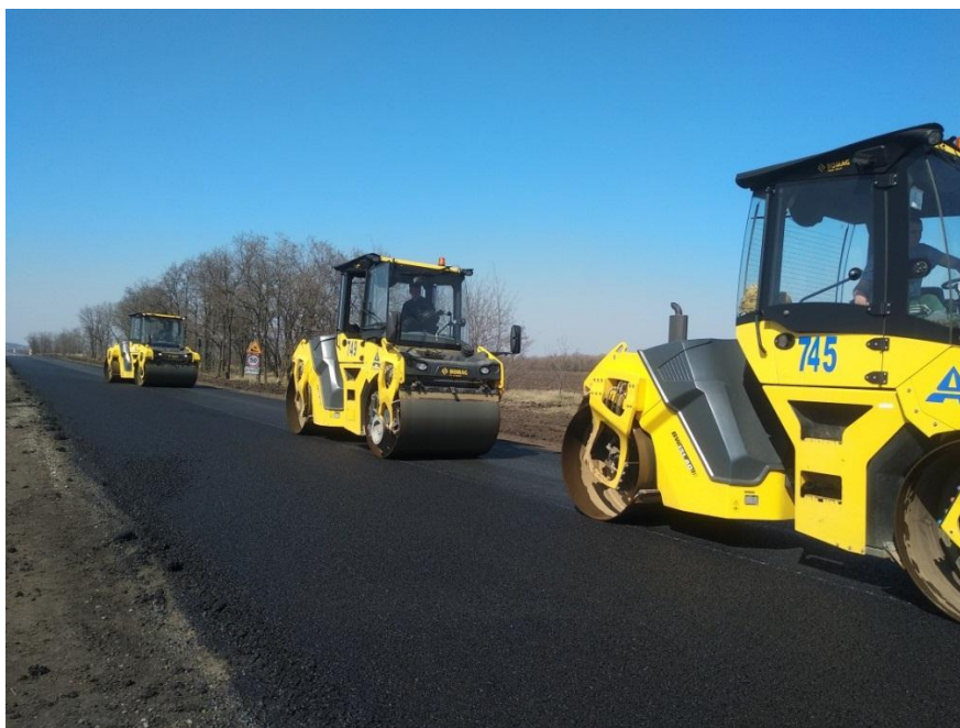
Рис. 5.8 – Ущільнення шару з щебенево-мастикової асфальтобетонної суміші гладковальцевими котками
