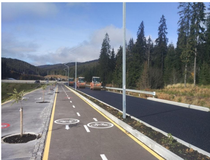
Рис. 5.17 – Ущільнення шару котками
