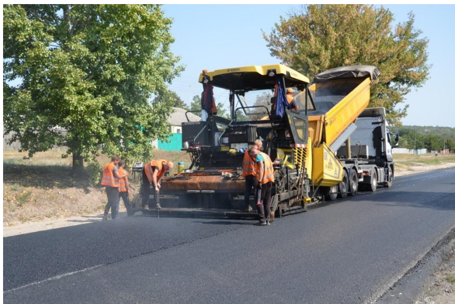
Рис. 5.9 – Укладання щебенево-мастикової асфальтобетонної суміші асфальтоукладачем
