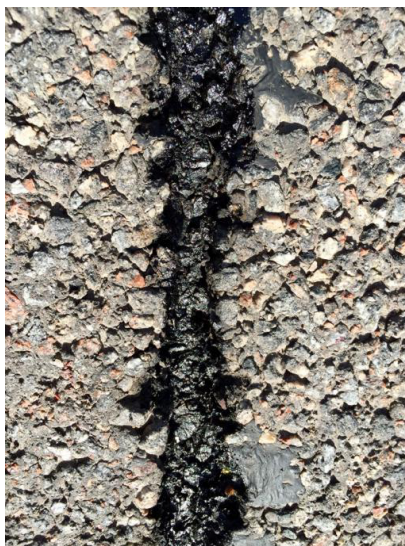
Рисунок 5.10 – Загальний вигляд жолоба відразу після застосування «ТЕПЛОВОГО СПИСА»
