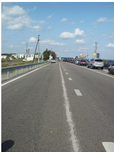
Рисунок 5.14 – Загальний вигляд свіжозагерметизованих та присипаних піском тріщин
