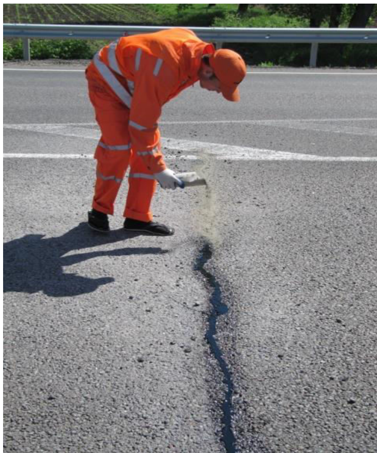
Рисунок 5.13 – Виконання технологічної операції присипання свіжозагерметизованої тріщини піском
