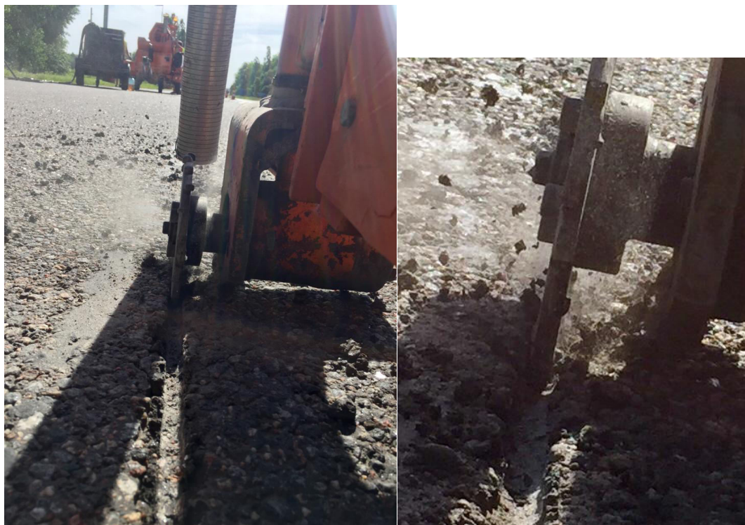
Рисунок 5.8 – Загальний вигляд робочого органу самохідного наріжчика жолоба
