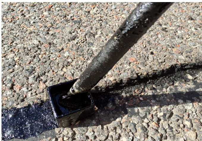
Рисунок 5.11 – Виконання технологічної операції заповнення створеного та прогрітого жолоба (а) без напуску (б) та з напуском (в) герметизуючого матеріалу на поверхню асфальтобетонного покриття
