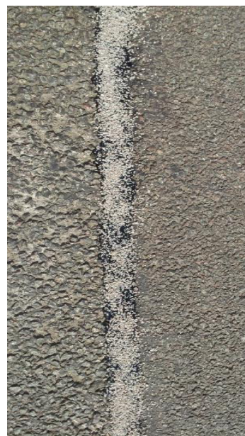
Рисунок 5.14 – Загальний вигляд свіжозагерметизованих та присипаних піском тріщин
