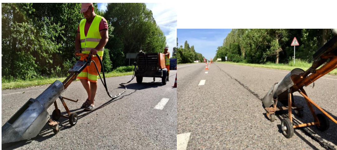
Рисунок 5.9 – Технологічна операція прочищення, висушування і нагрівання поверхні асфальтобетону в зоні жолоба струменем гарячого повітря під тиском з використанням «теплого списа»
