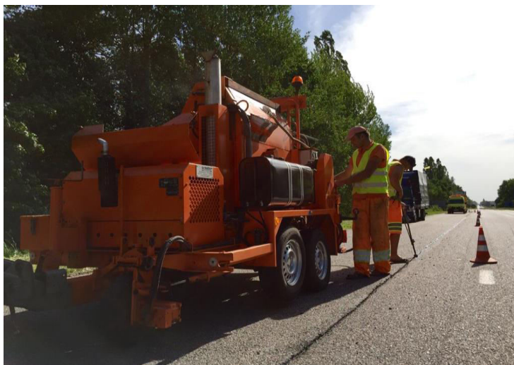
Рисунок 5.10 – Загальний вигляд жолоба відразу після застосування «ТЕПЛОВОГО СПИСА»
