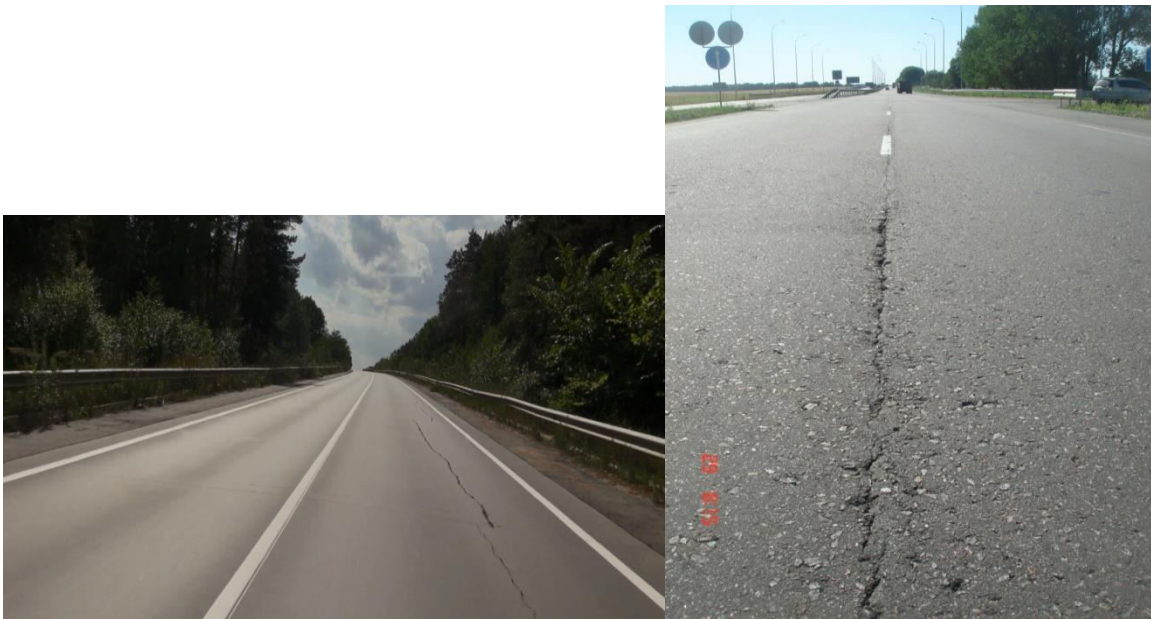
Рисунок 1.5 – Поздовжні тріщини
