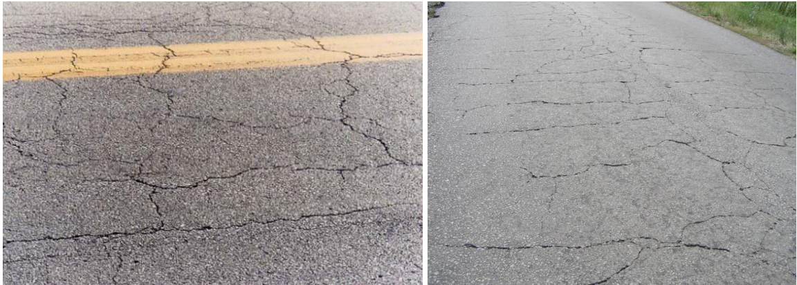
Рисунок 1.3 – Блочні тріщини [27]
