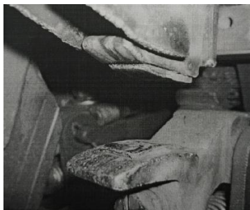
Рис. 4. Сліди оплавлення контактів електропневматичного контактора ПК-96-101 електровоза ВЛ80
