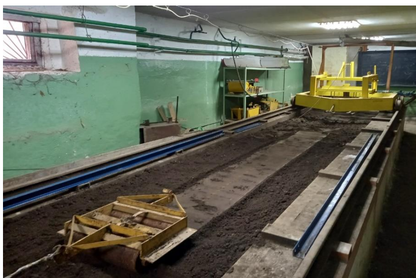
Рисунок 3.14 – Ущільнення ґрунту розкочувальними котками
