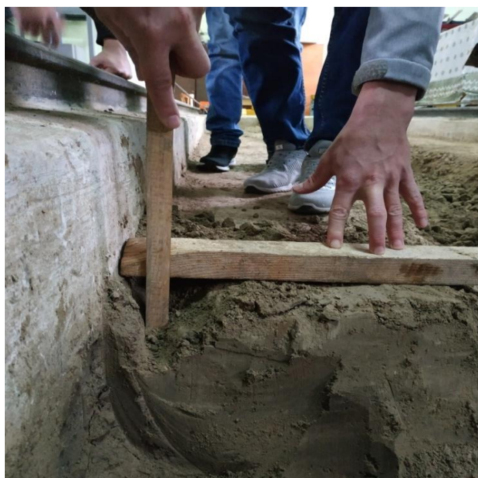
Рисунок 3.16 – Заміри глибин та бічних розширень прорізів
