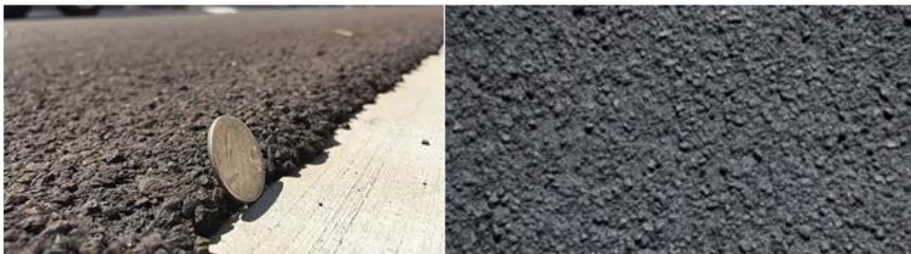
Рис 3 Структура поверхні влаштованого тонкошарового покриття з ЛЕМС
