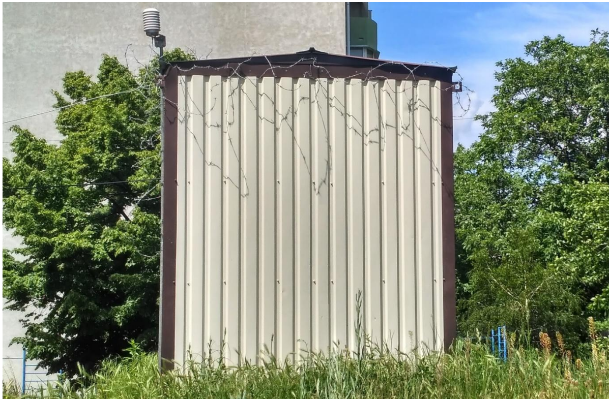
Рис. 1.2 – Розташування стаціонарного пункту спостережень ОДЕКУ з встановленим приладом AQT420 [3].
