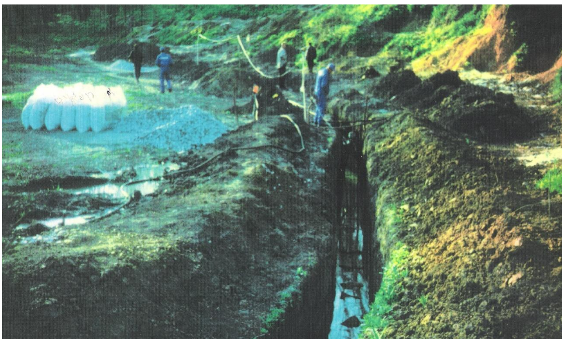
Рис. 10. Встановлення глибинного геохімічного бар'єру із мінерального сорбенту «Глауконіт» в районі розташування Солохівської ГС (Полтавська обл.)
