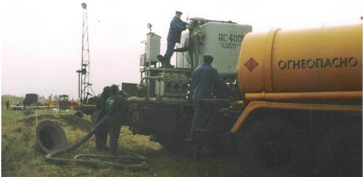
Рис. 2. Нанесення сорбентного екрану з глауконіту з допомогою компресора АС 400
