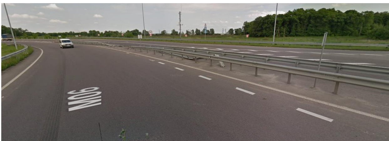
Фото 1, 2, 3 - Ділянка звуження дороги
