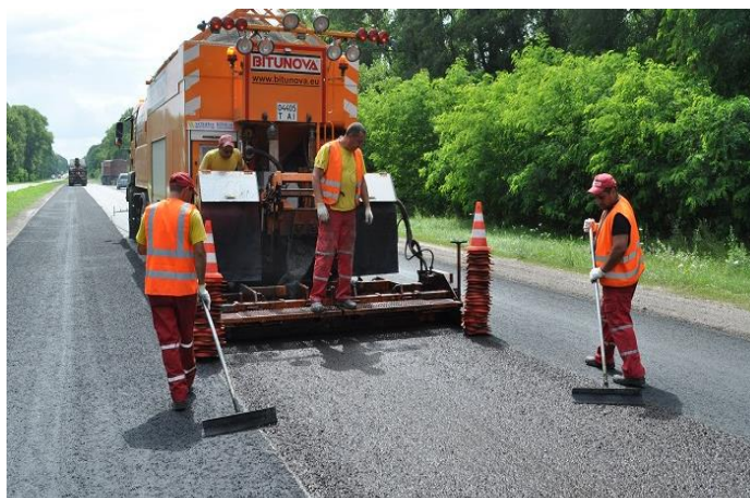
Рис.1 Влаштування ЛЕМС на а/д М 06 Київ - Чоп
