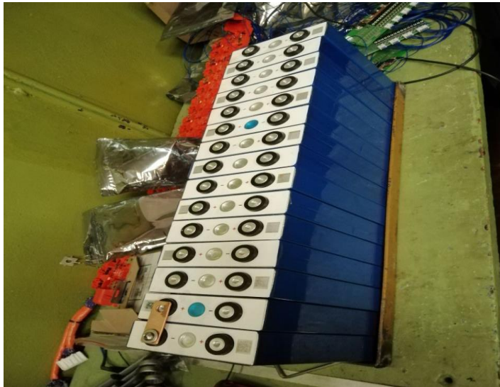
Рисунок 6 - Літій залізо фосфатні акумуляторні батареї LiFePO 4
