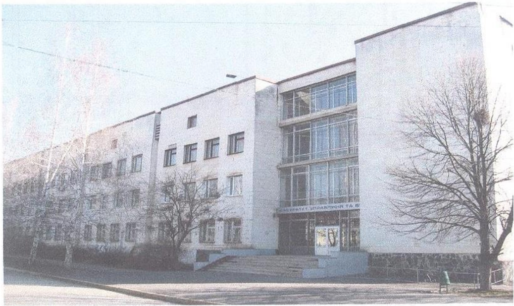
Рис. 1. Загальний вигляд фасаду будівлі учбового корпусу літ.А-4.
