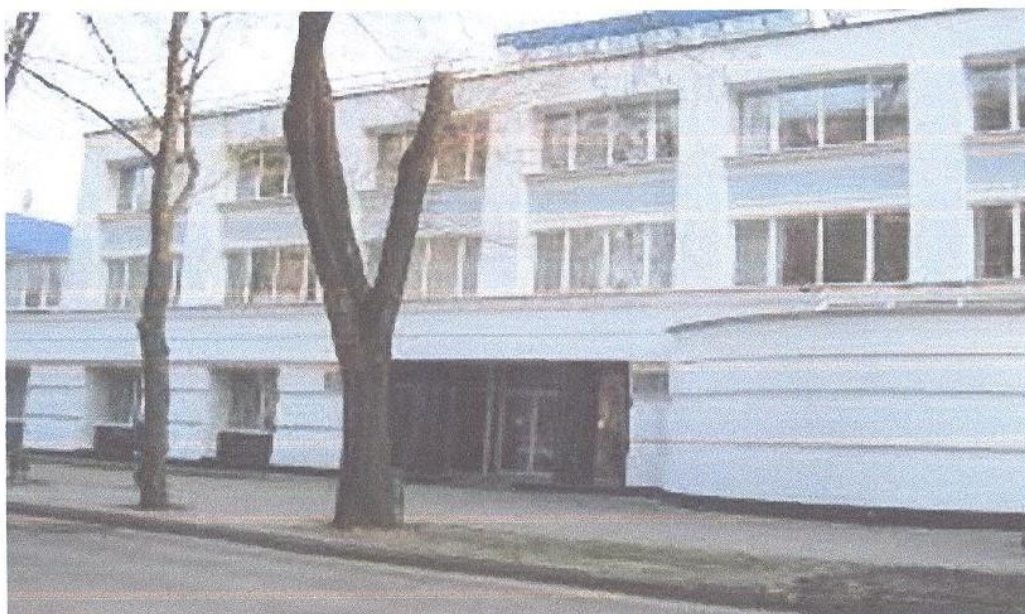
Рис. 1. Загальний вигляд фасаду будівлі учбового корпусу літ.Б-3 по вул.Каразіна,22.
