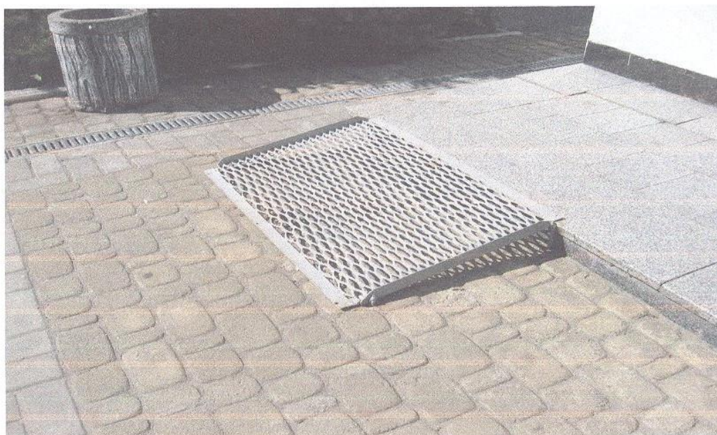
Рис. 2. Металева конструкція пандусу при вході у будівлю, осі 3-4, ряд А.
