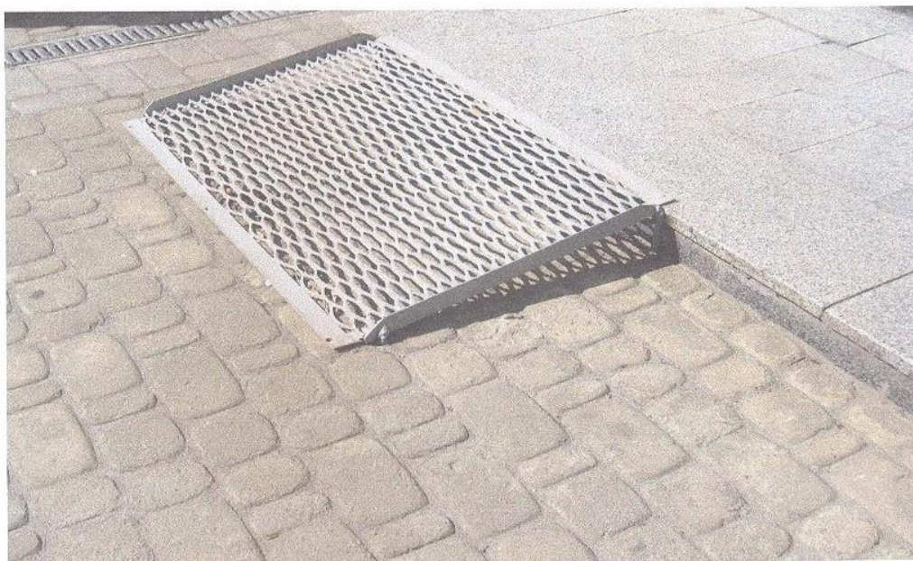
Рис. 2. Металева конструкція пандусу при входу у будівлю, осі 8-9, ряд К.
