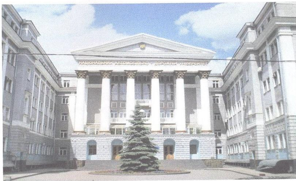
Рис. 1. Загальний вигляд фасаду будівлі «головного учбового корпусу» літ.А-5 по вул.Яр.Мудрого,25.
