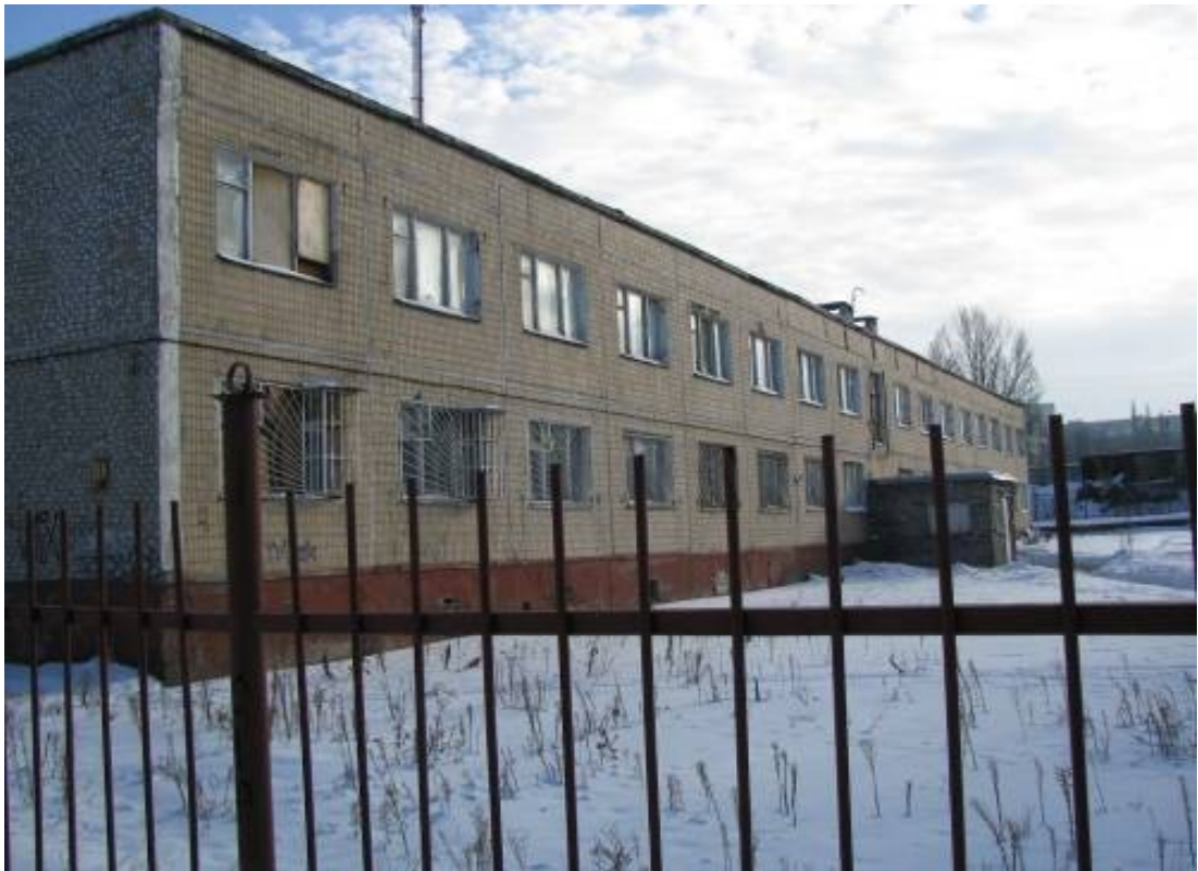
Рис. 23.1.1 Зовнішній вигляд технічної будівлі до реконструкції в житловий будинок (2008 р.)
