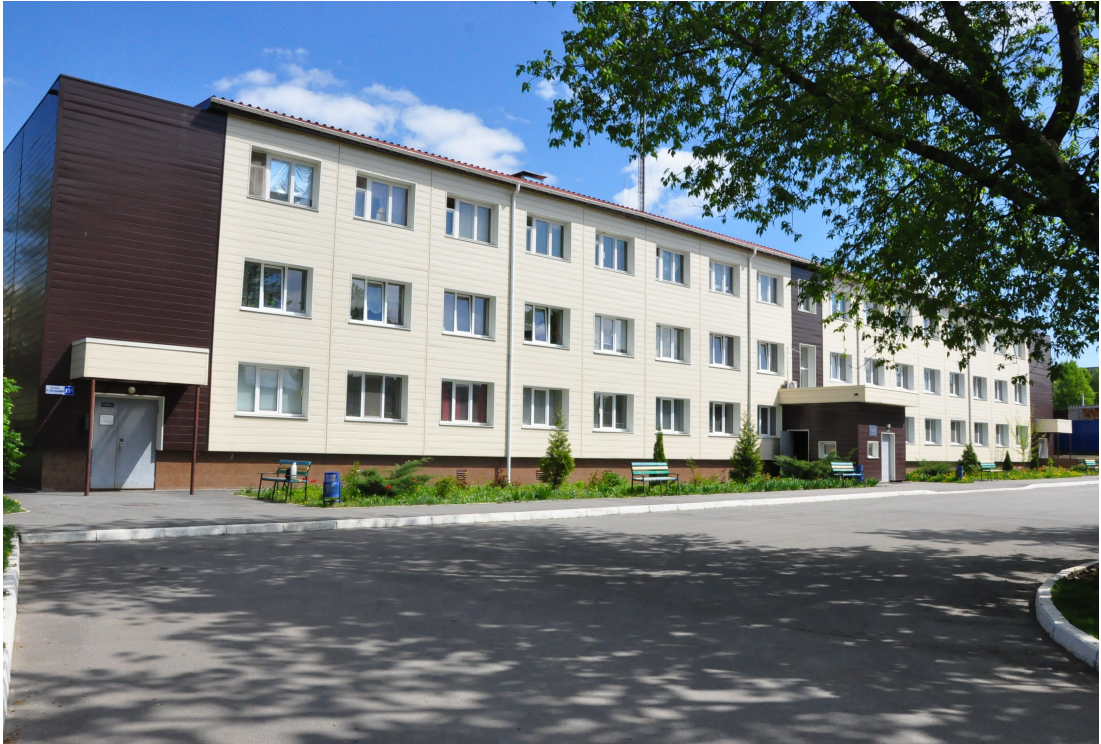
Рис. 23.1.3 Будинок на вул. Р. Ейдемана, 13 після реконструкції
