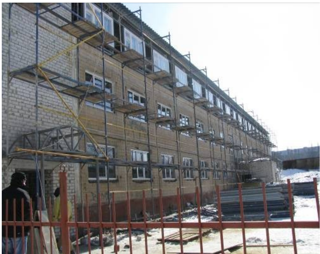
Рис. 23.1.2 Хід реконструкції технічної будівлі в житловий будинок (2009 р.)
